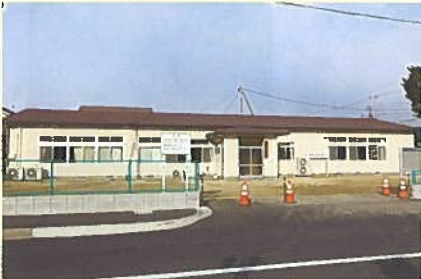
外壁塗装された公民館と整備された出入口
