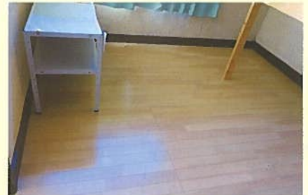
綺麗に補修した小ホール倉庫内部
